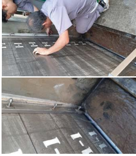
จากการตรวจสอบพบว่ายังไม่ได้ขันสกรูจึงทำให้รั่วไหลเข้ามาไม่ได้
