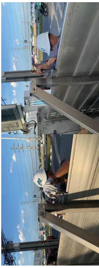
ทำการขันยึดสอตแฉ่นบานประตู( กดลงเพื่อให้บานประตูติดกันให้แน่น )
